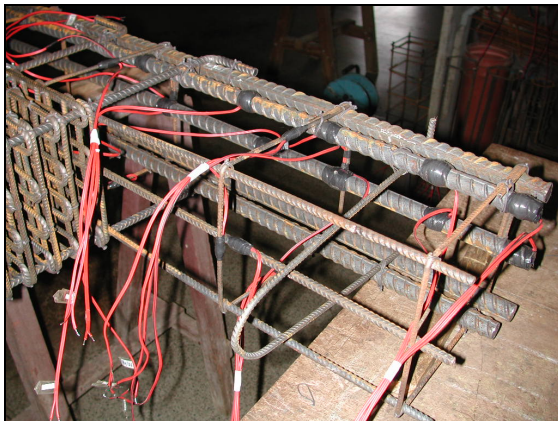
Figura 5.16 – Extensômetros instalados na armadura principal de tração, modelo B35P25E25e0.
