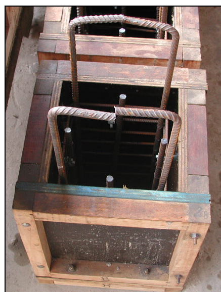
Figura 4.14 - Moldagem das estacas.
